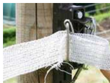
Step 2 Fissatelo con l'ardiglione e tendete il nastro.
