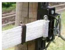
Step 4 Fissate il nastro in eccesso con le clips. Srotolate il nastro fino al prossimo tenditore o isolatore.
